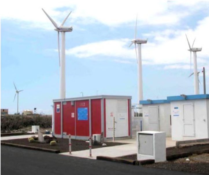
Planta de generación eólica con potencia configurada para producir hidrógeno in situ como sistema de almacenamiento de respaldo
