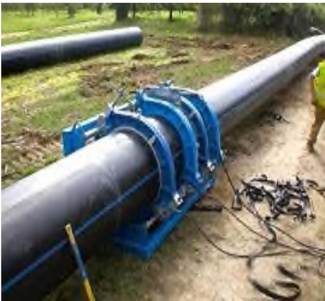
**Instalación mediante soldadura a tope y de electro fusión de tuberías de polietileno**
